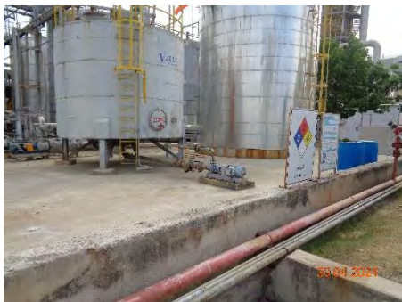
ภาพที่ 2.1-33 คันคอนกรีตล้อมรอบถังเก็บฟอรั่มลดีไฮด์
