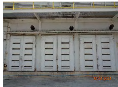
ภาพที่ 2.1-14 วัสดุปรุงรและห้องครอบ/ฝาครอบ เครื่องจักรที่มีเสียง
