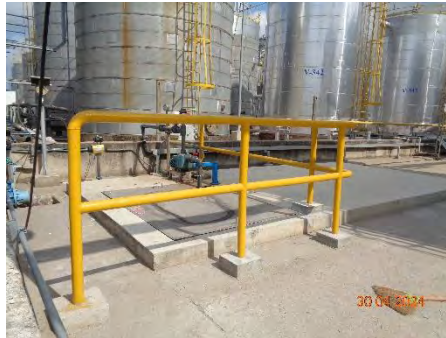
ภาพที่ 2.1-17 บ่อรองรับน้ำฝนปนเปื้อน
